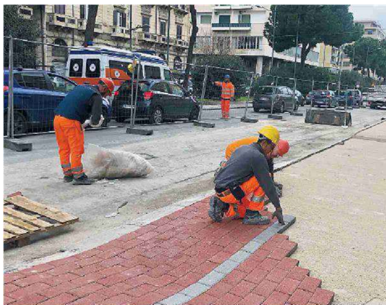
Operai al lavoro. Traffico e disagi in via Crispi FOTO ACAN
