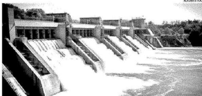
Concessioni idroelettriche. Bruxelles pretende il rispetto della concorrenza
