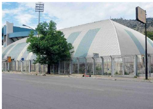
Viale del Fante. La struttura del «Pallone» dove si vorrebbe piazzare una piscina prefabbricata
