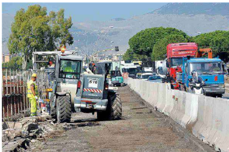
Circonvallazione. Lavori sul Ponte Corleone e disagi alla circolazione
