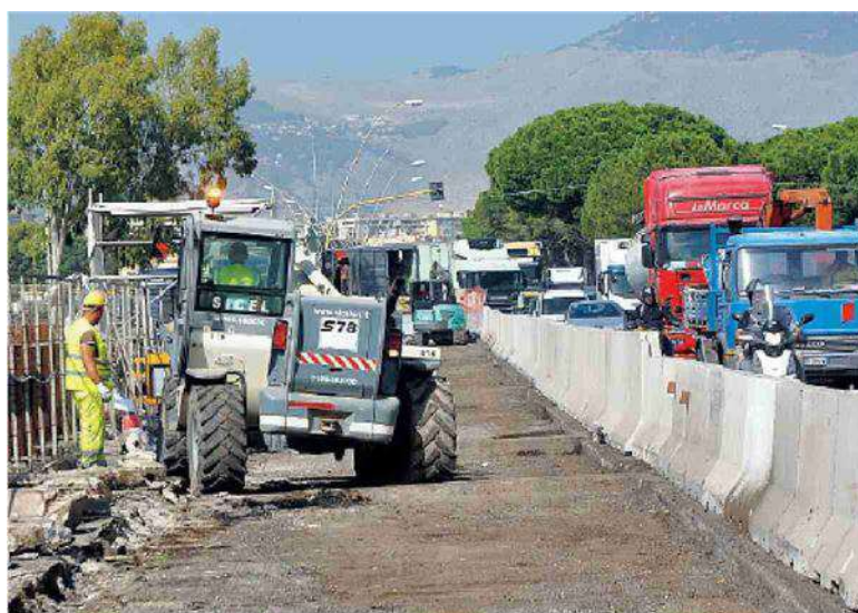
Viale Regione. I lavori sul ponte Corleone FOTO FUCARINI
