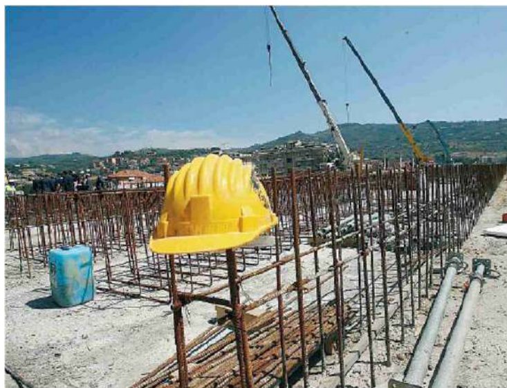
Edilizia. Centinaia di cantieri fermi per il caro-prezzi
