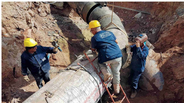
Rete idrica Un intervento di riparazione su una condotta che attraversa il territorio peloritano
