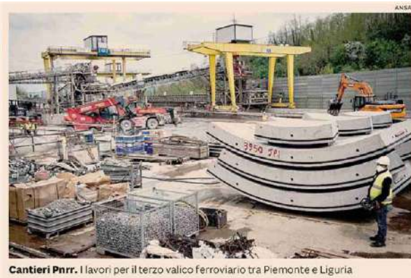
Cantieri Pnrr. I lavori per il terzo valico ferroviario tra Piemonte e Liguria
