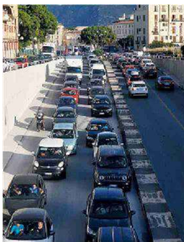
Di nuovo. Altri lavori in via Crispi
