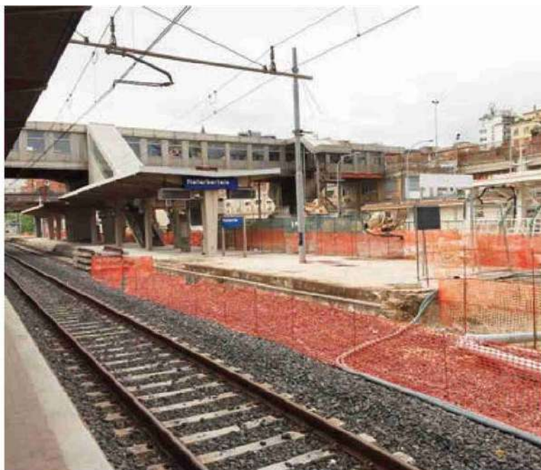
I cantieri del Passante (gi)
