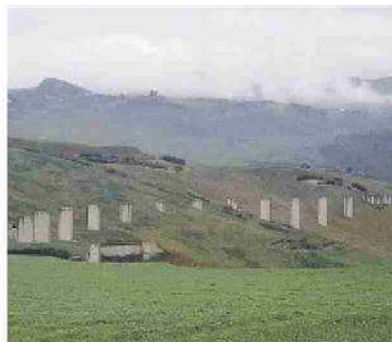
I piloni della strada mai realizzata
