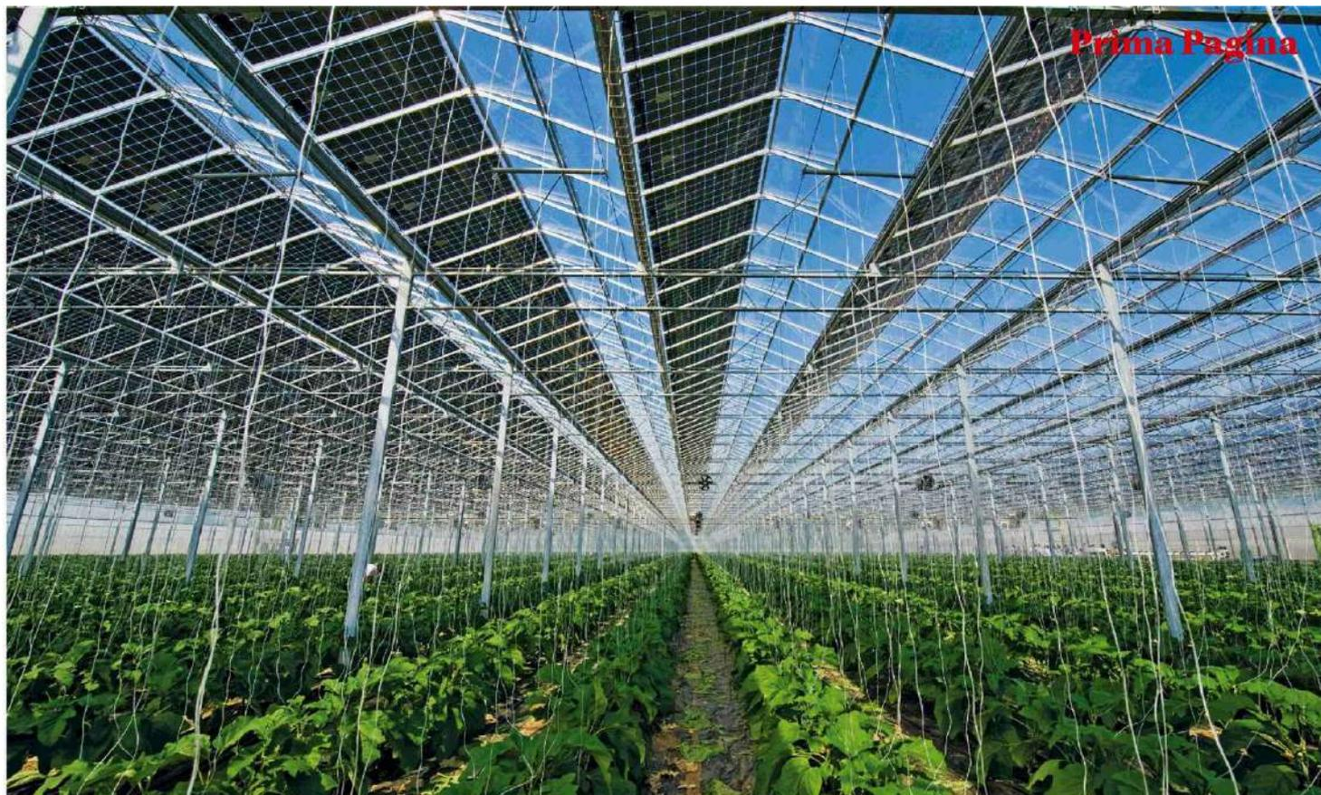
Impianti con pannelli fotovoltaici sospesi che consentono comunque la coltivazione di alcune colture. Nel Pnrr non saranno dati incentivi all'installazione di strutture a terra in campi agricoli. Solo per l'agrivoltaico sono previsti 3 miliardi di euro
