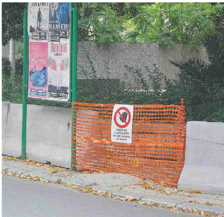
Lavori in corso. L'area recintata di piazza Principe di Camporeale FOTO FUCARINI
